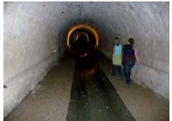
L'intérieur du bief
